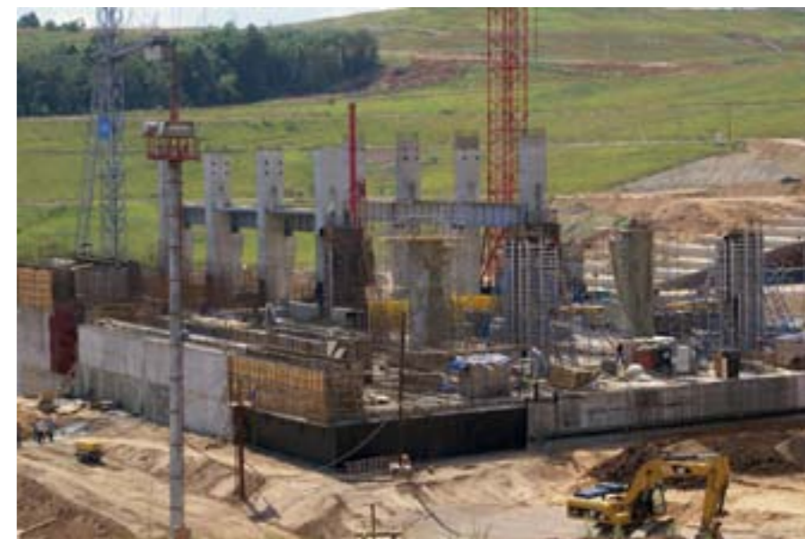
Работы на монтажной площадке станционного узла
