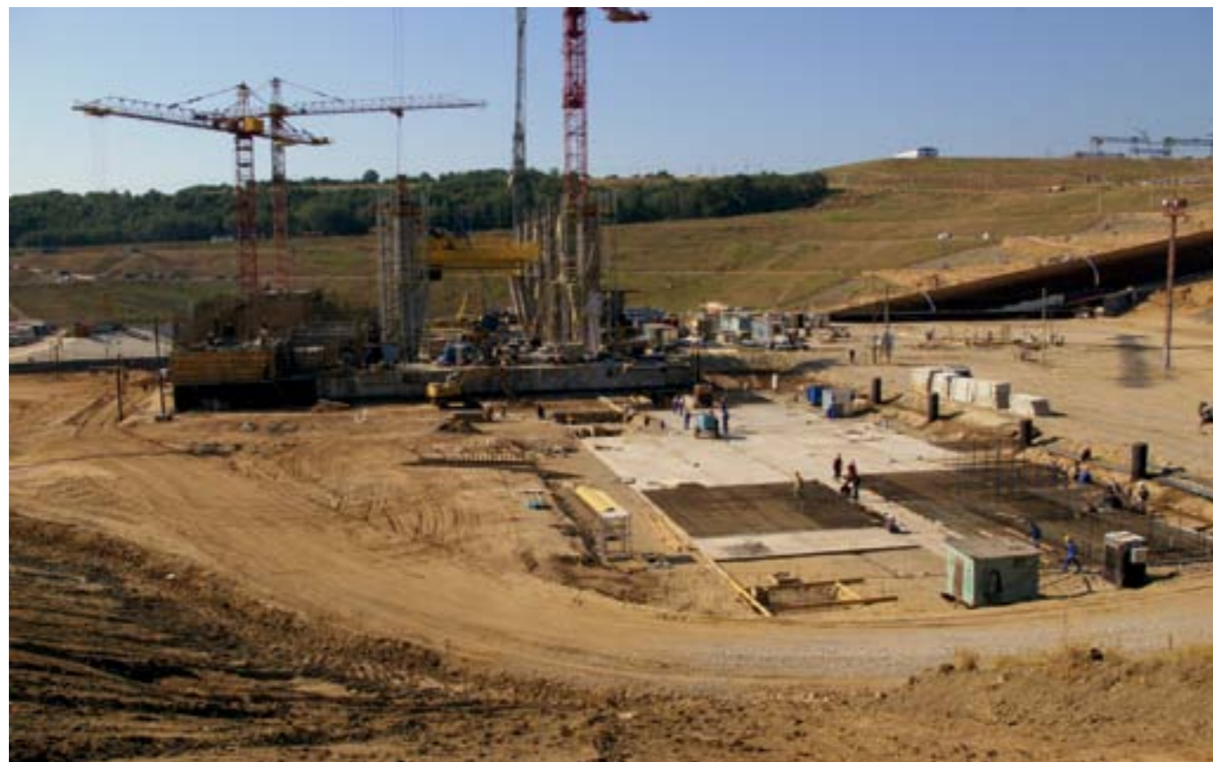
Строительно-монтажные работы на монтажной площадке станционного узла
