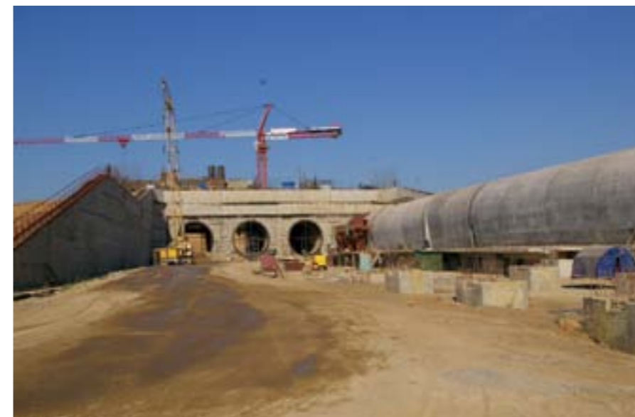
Реверсивный водоприемник работы по бетонированию плиты понура
